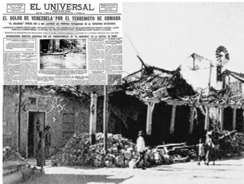
Figura 3. Aspecto de las casas en el terremoto en Cumaná 1929
