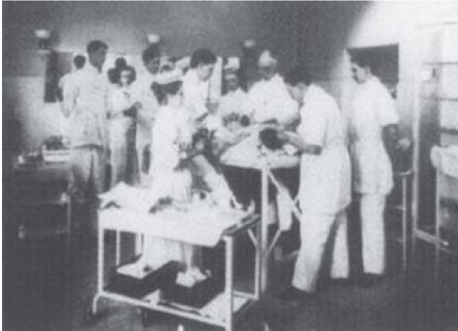
Fig 7 Mc Burney operando en el quirófano William Sims, alrededor de 1900 (Tomado de Clemons B.J. The first modern operating room in America. AORN Journal 2000; 71:164-170)
