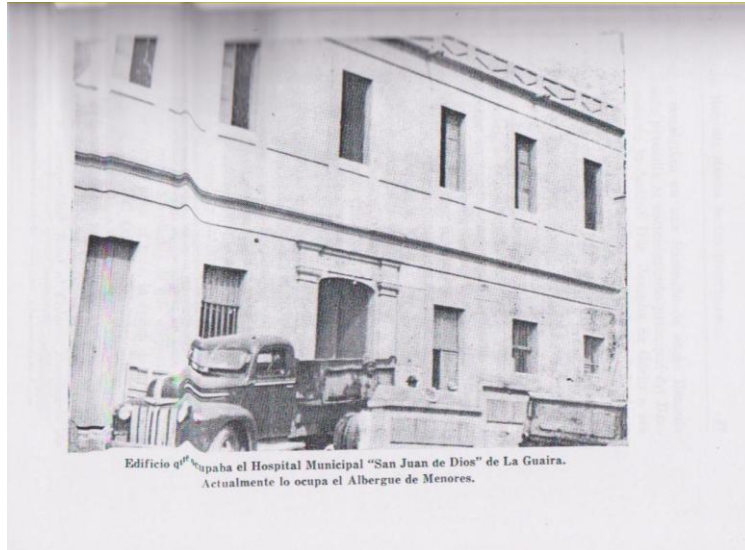
Hospital San Juan de Dios, La Guaira
